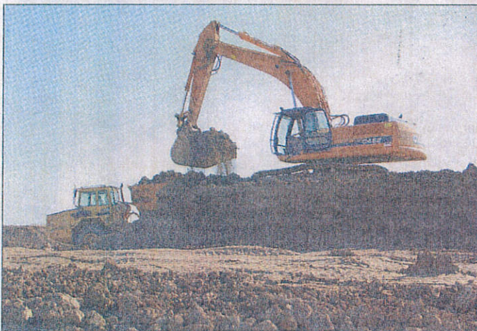
Les travaux sur la digue nord de Charron et celles de Marans pourraient débuter en 2017.
